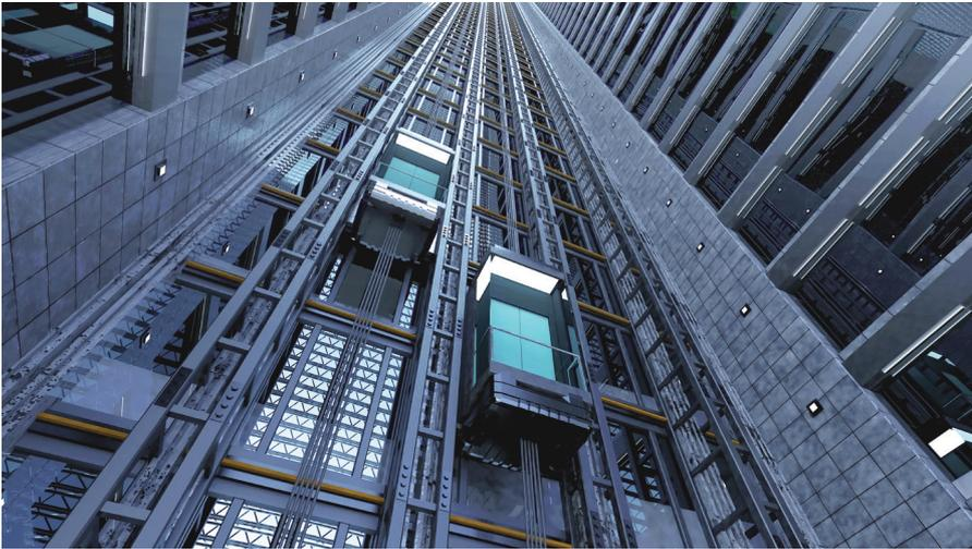
*Herkömmliche Seilauzüge benötigen mit zunehmenden Fahrgastzahlen mehr Verkehrsfläche durch zusätzliche Aufzugschächte und bei großen Förderhöhen zusätzliche Aufzugssysteme.*
